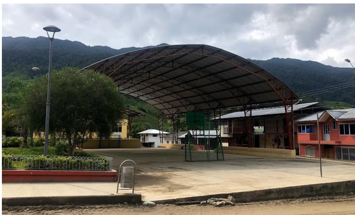
Imagen 24: Cancha cubierta de la Parroquia Bermejós Fuente: Equipo consultor PDOT 2020 Elaboración: Equipo consultor PDOT 2020
