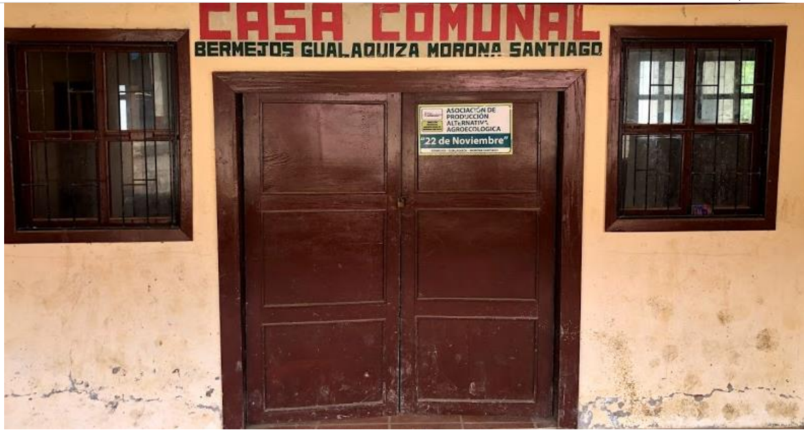
Imagen 21: Casa comunal de la Parroquia Bermejós
